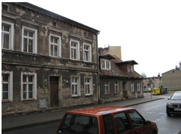
Zdjęcie 1. ul. Ojca Maksymiliana Kolbe w Pile – podobszar rewitalizacji Osiedle Śródmieście.
