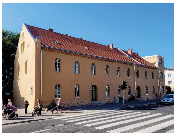
Fot. 5. Budynek dawnego arsenału
