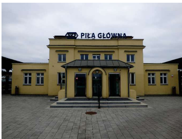
Fot. 18. Zespół stacji kolejowej Piła Główna
