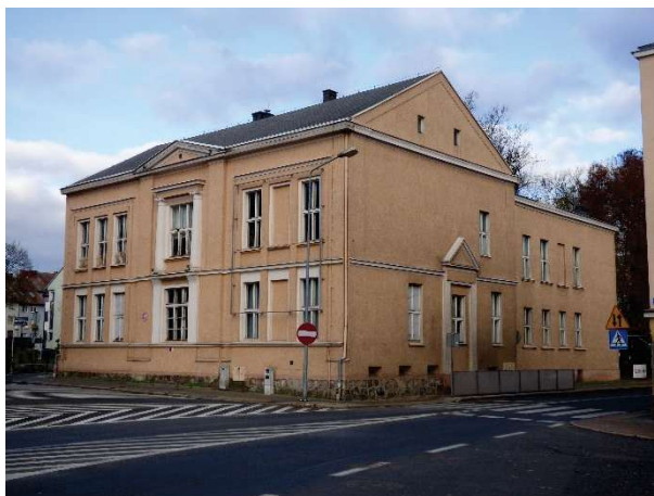
Fot. 8. Budynek dawnej loży masońskiej Borussia
