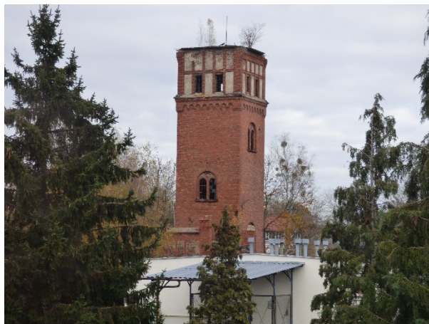
Fot. 20. Wieża ciśnień w kompleksie piecowni, w zespole Gazowni Miejskiej
