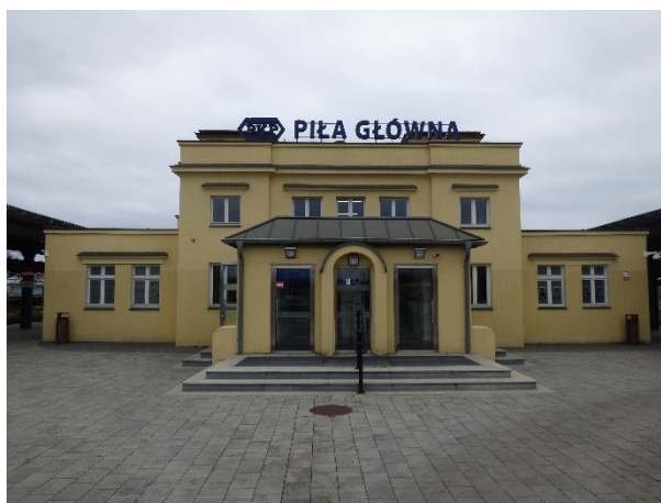
Fot. 18. Zespół stacji kolejowej Piła Główna
