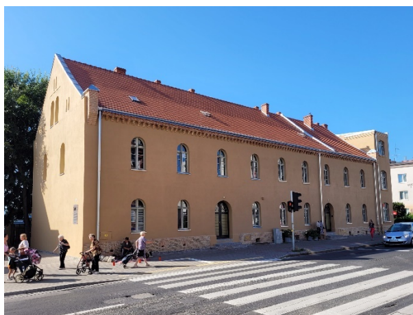
Fot. 5. Budynek dawnego arsenału
