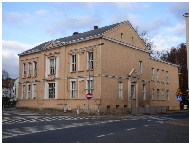
Fot. 8. Budynek dawnej loży masońskiej Borussia
