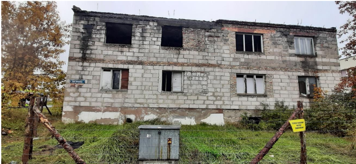
(kontrola nieużytkowanych budynków o złym stanie technicznym)
