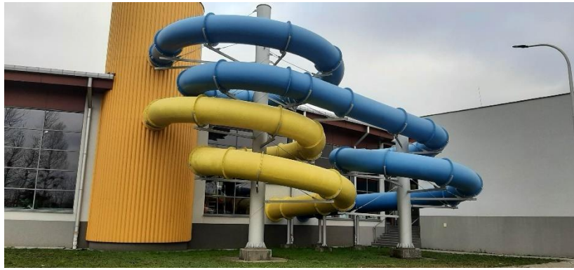
( budynek Centrum Rekreacji Wodnej AQUA-PIL - kontrola stanu technicznego użytkowania)
