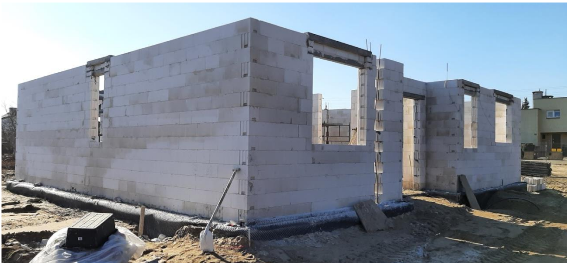
( kontrola budowy budynku mieszkalnego)
