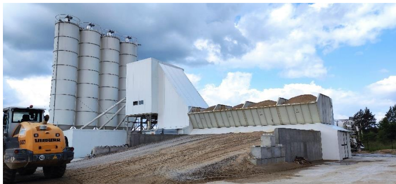
(kontrola budowy Zakładu Produkcji Betonu w Pile)
