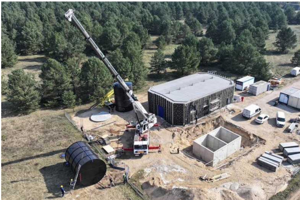
Montaż zbiorników retencyjnych oraz budowa odстойника
