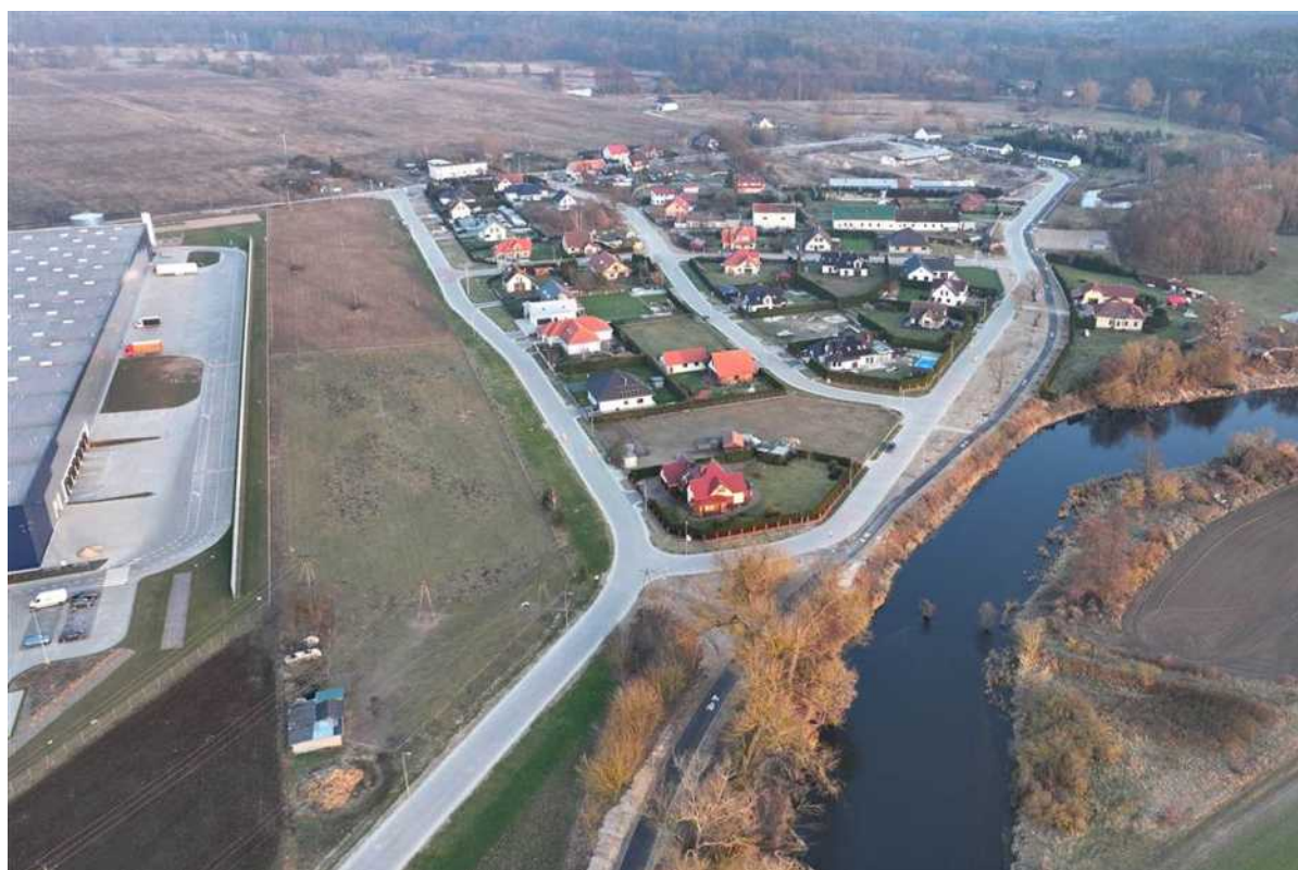
Nowo wybudowana infrastruktura drogową na osiedlu Motylewo oraz droga pieszo-rowerowa wzdłuż rzeki Gwdy
