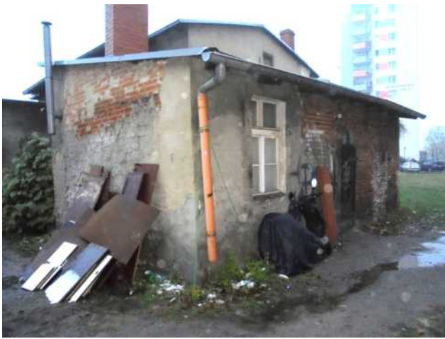
ul. Bydgoska 100 – po rozbiórce
