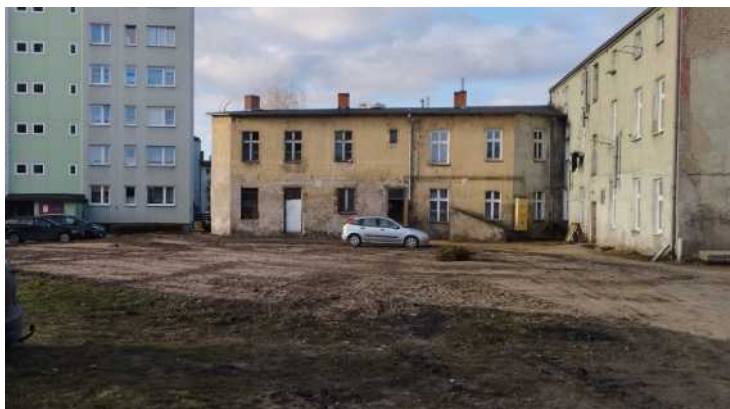
ul. Bydgoska 71 – przed rozbiórką
