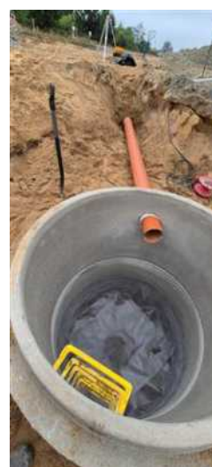
W ramach budowy drogi zbiorczej wykonano pierwsze odcinki sieci wodociągowej i kanalizacji sanitarnej
