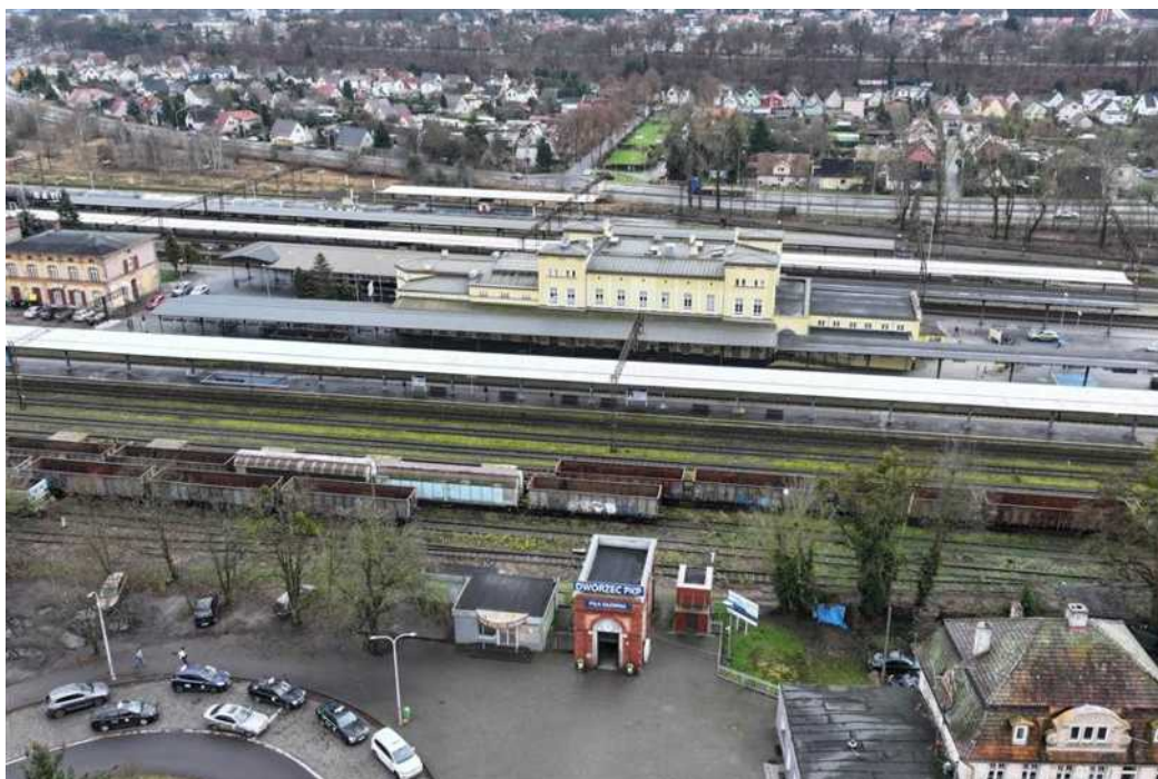
Planowana jest rozbudowa przejścia podziemnego w rejonie dworca PKP
