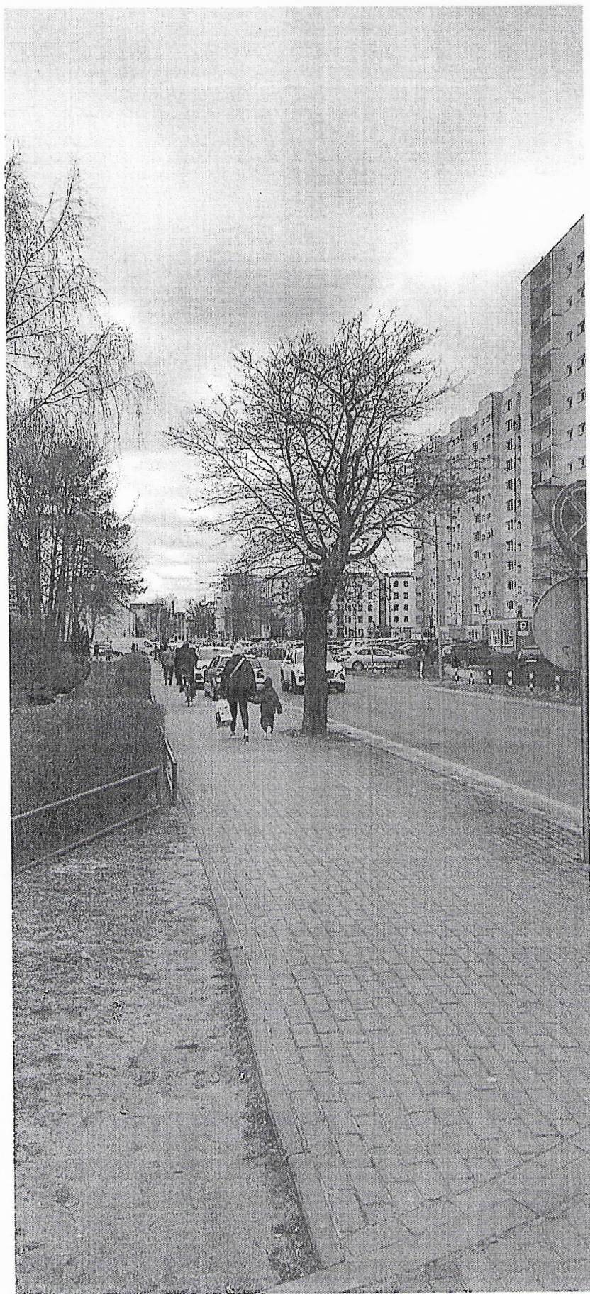
Zdj.2 Zwężenie chodnika przez zaparkowane samochody.
