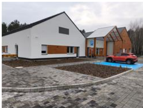
Rycina 2 Nowy budynek Publicznego Przedszkola Nr 16 w Piłe (źródło – opracowanie własne PSSE w Piłe)
